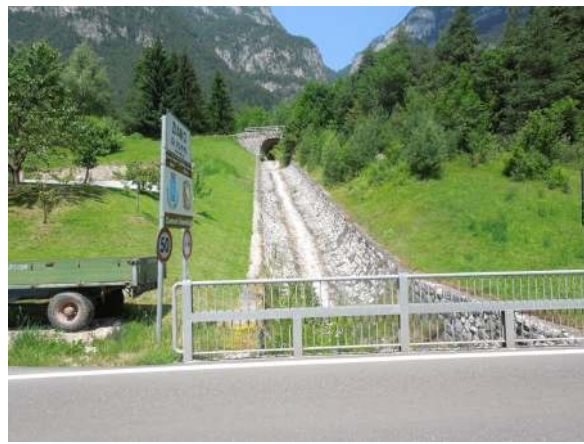
(a) Torrente Larganza a Roncegno in cui la sezione ampia e il particolare regime idrologico consentono una folta crescita di vegetazione, tipologia C2 (b) Cunettone sul Rio Val Averta in Val di Fiemme, tipologia C3
