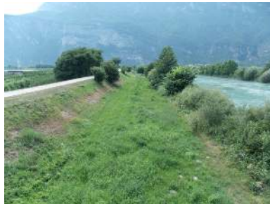
(c) 3: Fiume Adige a Zambana (tipologia F8), con golena condotta a prato, sponda molto ripida ma boscata e radi cespugli anche sul rilevato arginale (Ph. Giuliano Trentini).
