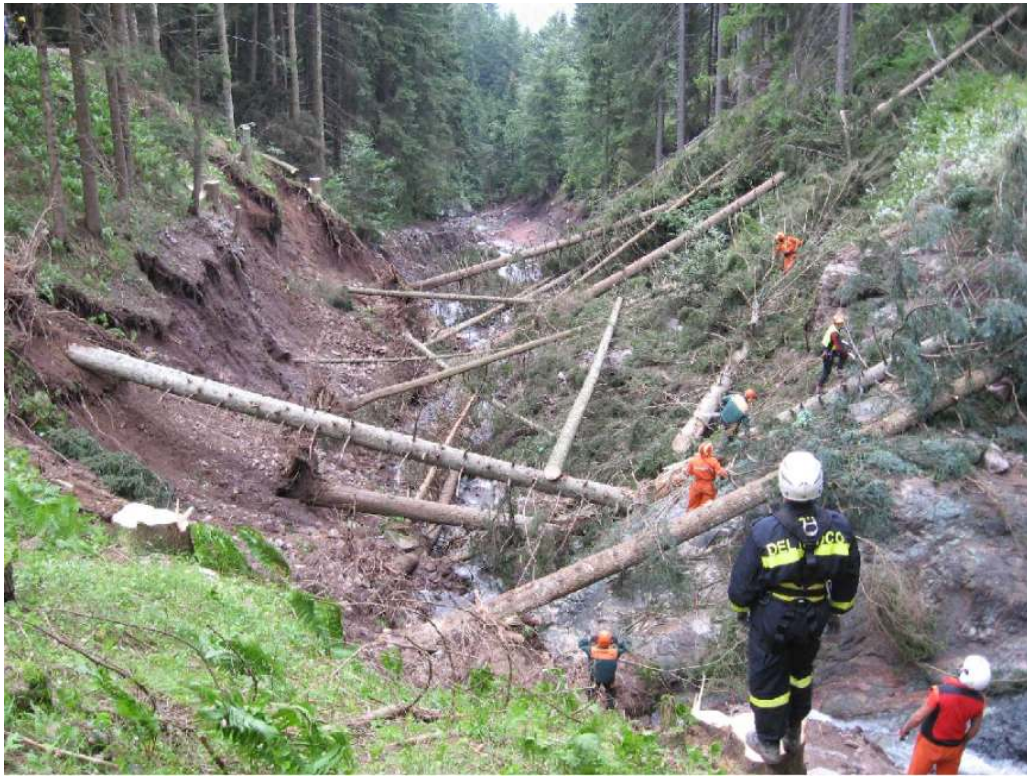
Figura 2.8: Recupero schianti susseguente la colata detritica del 15 agosto 2010 sul Rio Val Molinara. (Ph. Servizio Bacini Montani della Provincia Autonoma di Trento).
