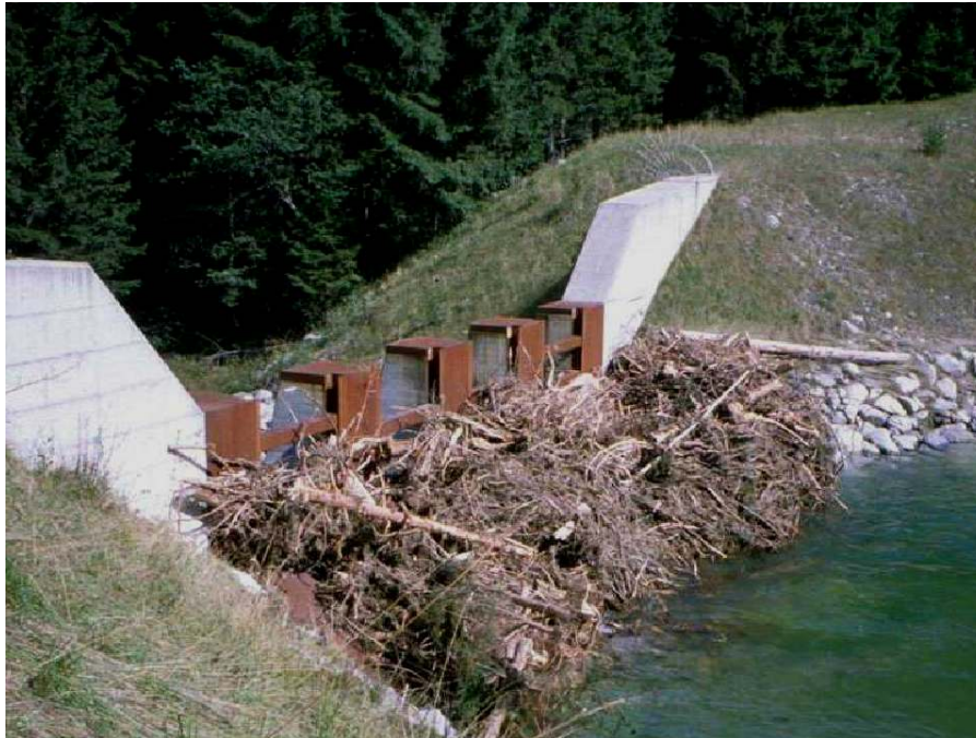
Figura 2.12: Esempio di briglia selettiva (Ph. Servizio Bacini Montani della Provincia Autonoma di Trento).
