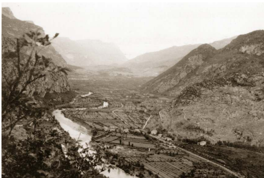
Figura 2.14: Tratto di Sarca a monte di Arco rettificato a fine 800 secondo il progetto in Fig. ??, è evidente la pressoché totale assenza di vegetazione lungo le sponde. (Fonte: Archivio storico del Comune di Arco).
