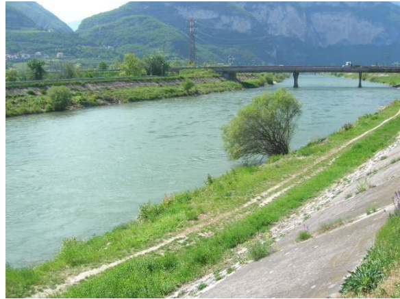
(b) 4: Fiume Adige a Trento, si può osservare il paramezzo interno del rilevato arginale protetto da una lastra in cemento armato e la presenza di radi cespugli (Ph. APPA).
