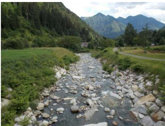
(a) Prepotente ingresso sul tratto terminale del Rio Be- (b) Diversamente la penetrazione nelle valli dell'Avisio dù di Pelugo a seguito del rifacimento delle opere di è solo all'inizio, questo piccolo nucleo si trova a Moli- difesa, in Val Rendena la diffusione di questa specie è na di Fiemme lungo un tratto di sponda quasi privo di particolarmente virulenta vegetazione arborea e arbustiva
