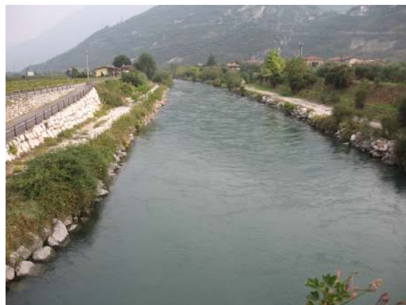
(b) 2: Fiume Sarca a Torbole, si possono notare la scogliera al pieded i sponda e la pista di servizio protetta tramite una lastra in cemento armato (Ph. Giuliano Trentini).
