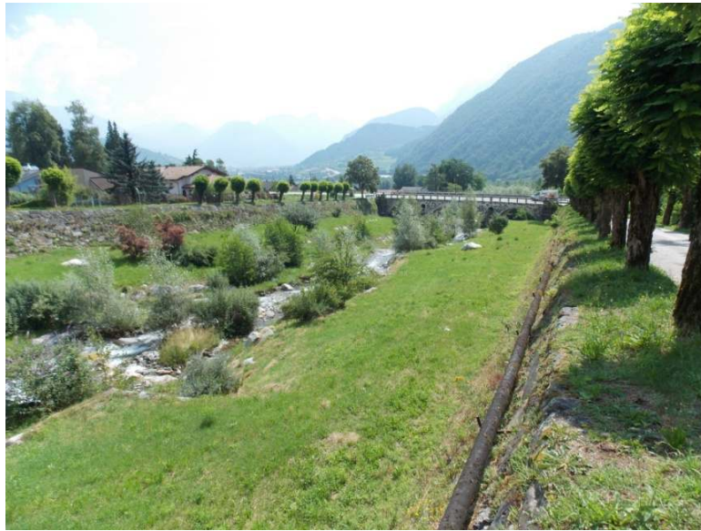
Figura 2.33: Torrente Larganza a Roncegno oggetto di un intervento di riqualificazione dell'alveo compreso tra i muri spondali, assicurando la formazione di un canale di magra e di un corteggio di vegetazione riparia lungo di esso (che deve crescere ulteriormente). Considerando che spontaneamente la situazione sarebbe quella in Fig. 2.32(a), questo assetto appare un buon compromesso tra le diverse esigenze (Foto: Giuliano Trentini).
